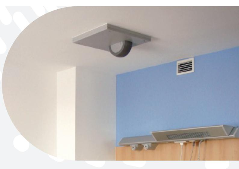
Das PADOS ist ein PC-gestütztes Messsystem zur dosimetrischen Überwachung von Patienten auf Radioiodtherapie-Stationen.
